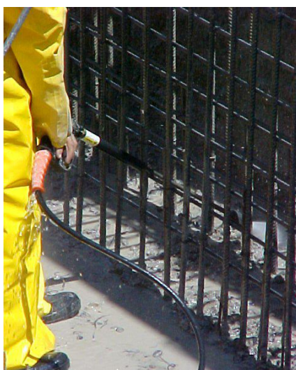
Escarificação e limpeza
