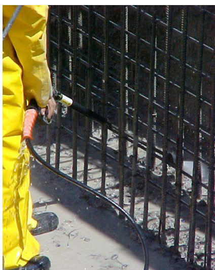
Escarificação e limpeza
