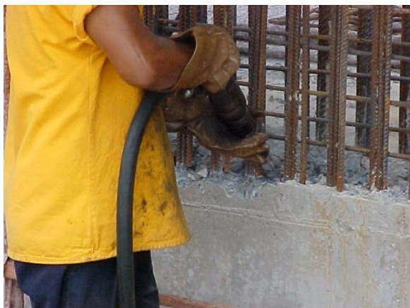
Escarificação, limpeza, colocação do espaçador e selante expansivo
