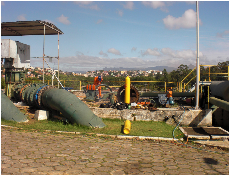
Fig. 10 CANTEIRO DE OBRAS
