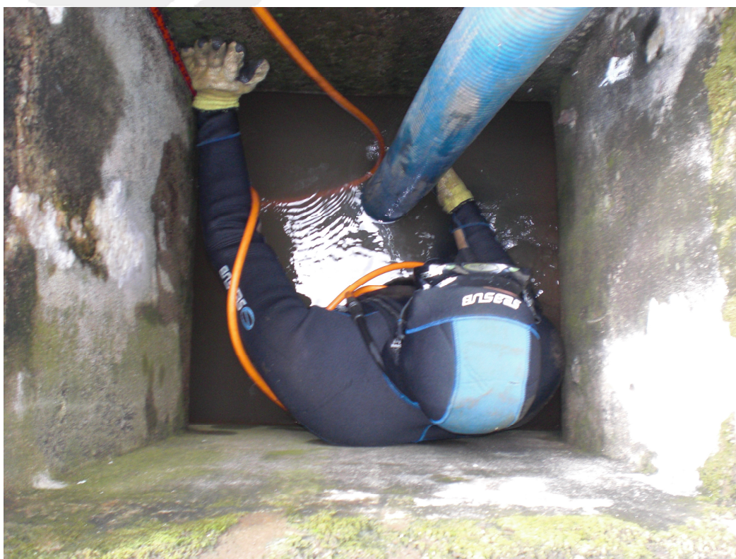
Fig. 15 MERGULHADOR PREPARADO PARA EXECUÇÃO DA DRAGAGEM.
