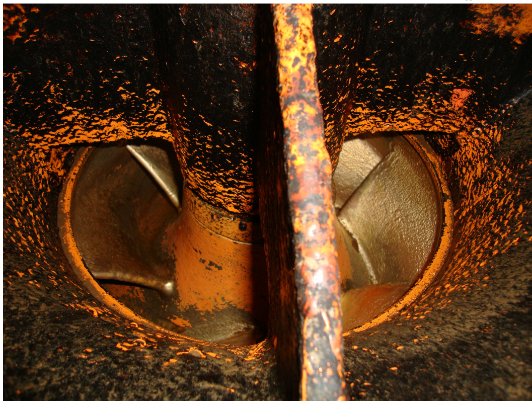
Fig. 4 crivo da bomba limpo após retirada de detritos.
