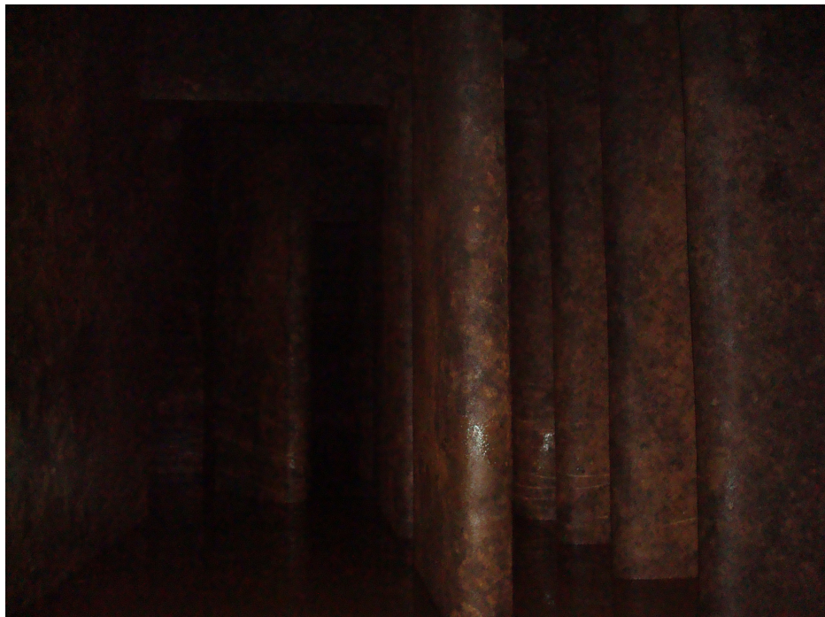
Fig. 24- Checagem na galeria e verificação ausência de sedimentos e detritos.
