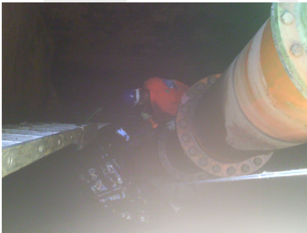
Fig. 3 trabalhadores vistoriando e retirando detritos na área das bombas.
