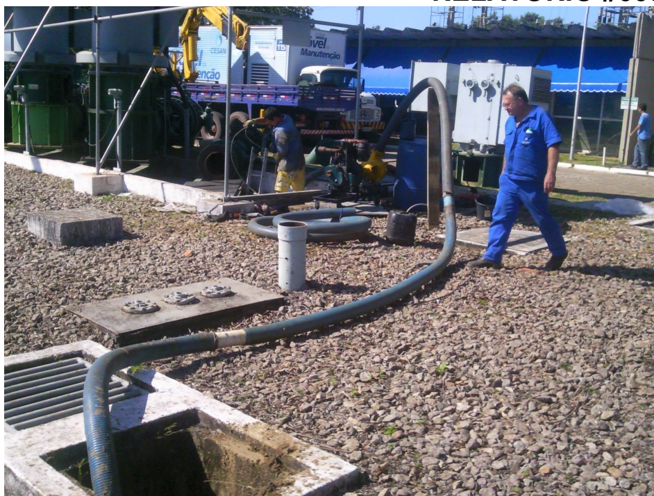
Fig. 8 DRAGAGEM NUM DOS POÇOS DE SUCCÃO .
