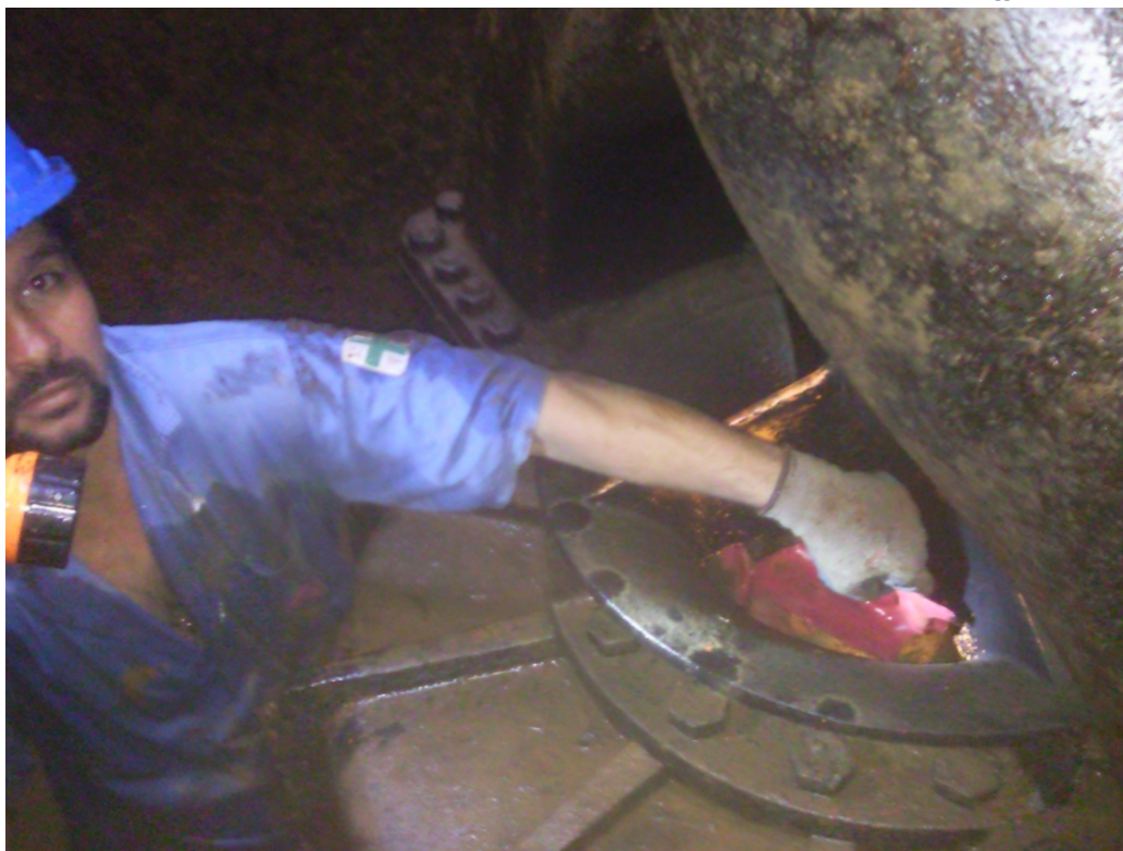
Fig. 2 retirada de detritos no crivo das bombas de sucção da elevatória
