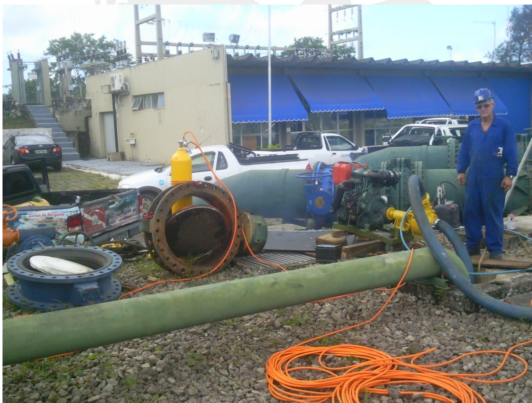
Fig.1 Area e equipamentos de trabalho
