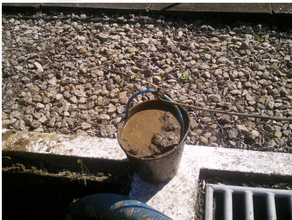
Fig. 7- Lama retirada num dos poços de sucção.
