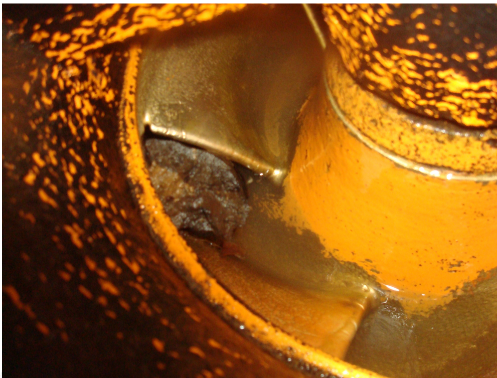
Fig. 20- pedaço de madeira encontrado no crivo de uma bomba de sucção.
