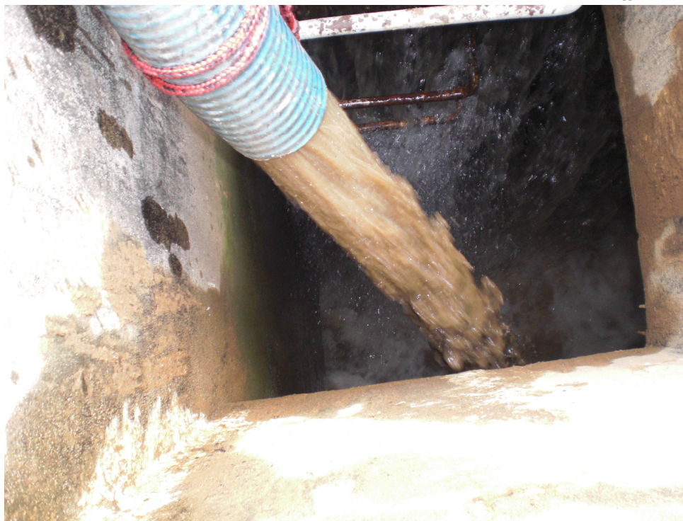
Fig. 16 – MATERIAL SENDO DESCARTADO PELA DRAGA.
