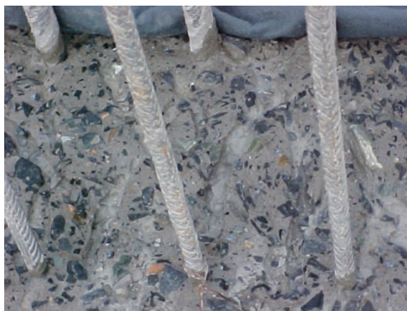
Escarificação, limpeza, colocação do espaçador e selante expansivo
