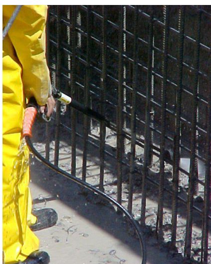
Escarificação e limpeza
