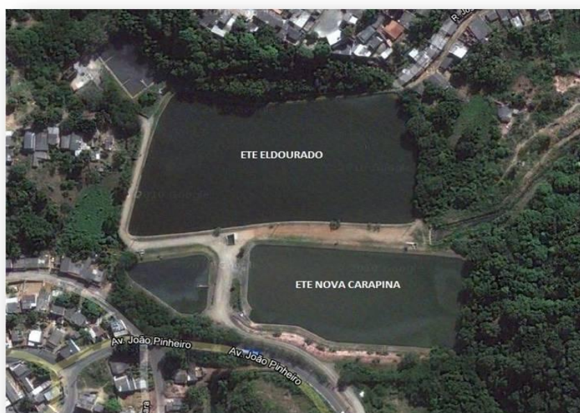
Figura 21 - Visão geral do ETE Eldorado
