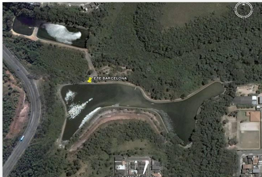
Figura 17 - Visão geral do ETE Barcelona
