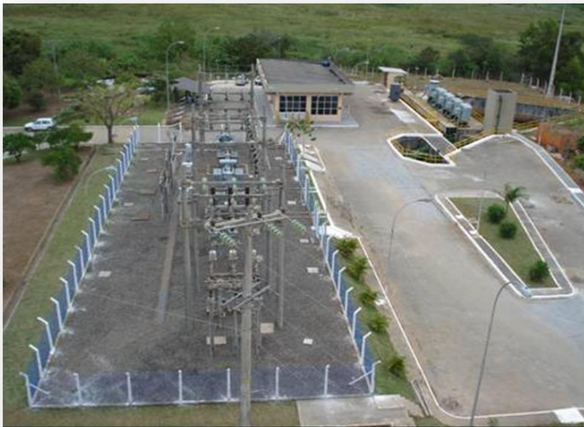
Figura 9 – Captação do subsistema Carapina
