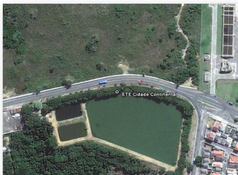
Figura 18 - Visão geral do ETE Cidade Continental
