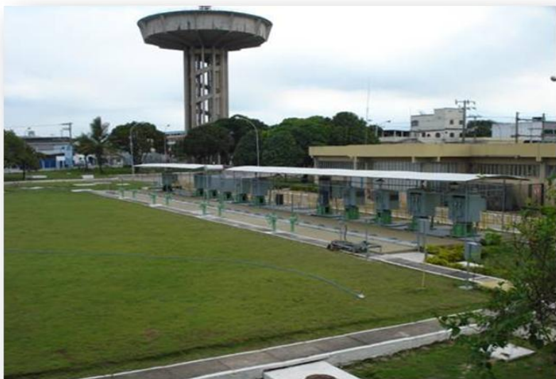
Figura 11 – Elevatória e Recalque de Água Tratada Planalto
