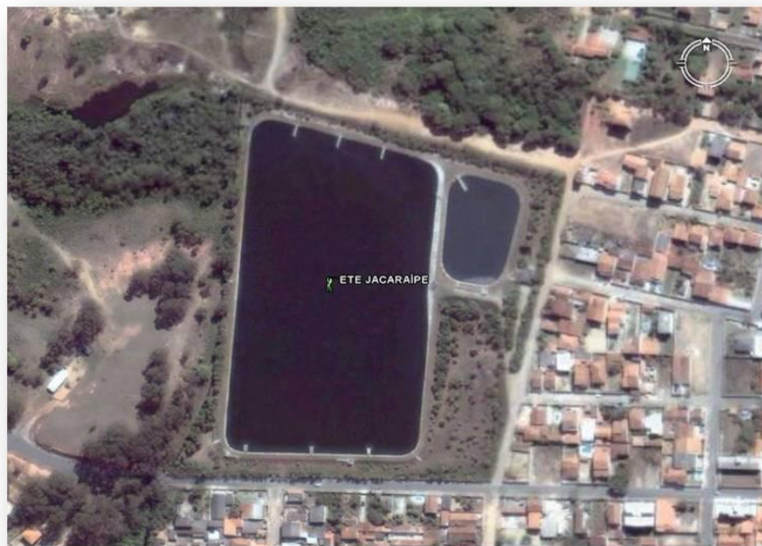
Figura 24 - Visão geral do ETE Jacaraípe
