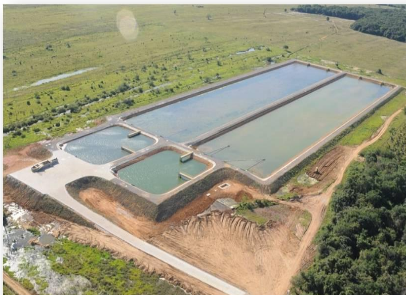
Figura 31 - Visão geral do ETE Nova Almeida
