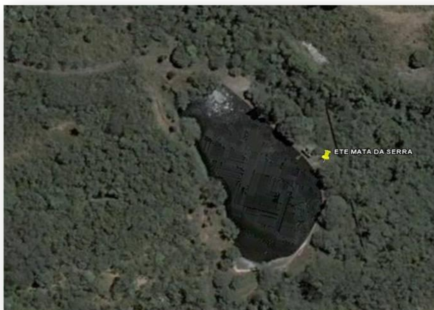
Figura 30 - Visão geral do ETE Mata da Serra
