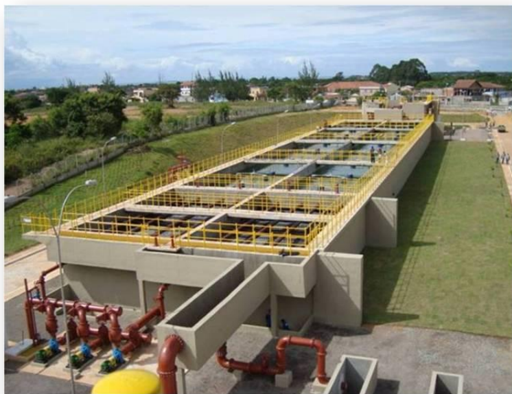
Figura 28 - Visão geral do ETE Manguinhos
