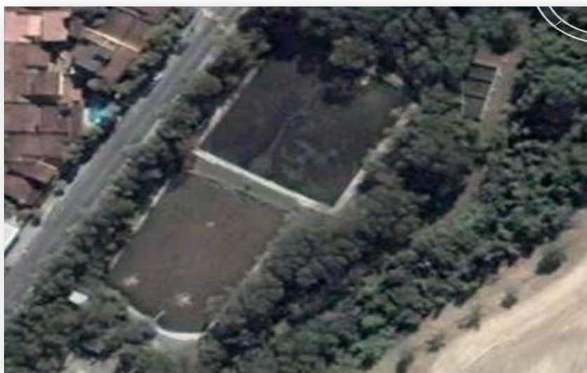
Figura 36 - Visão geral do ETE Valparaíso
