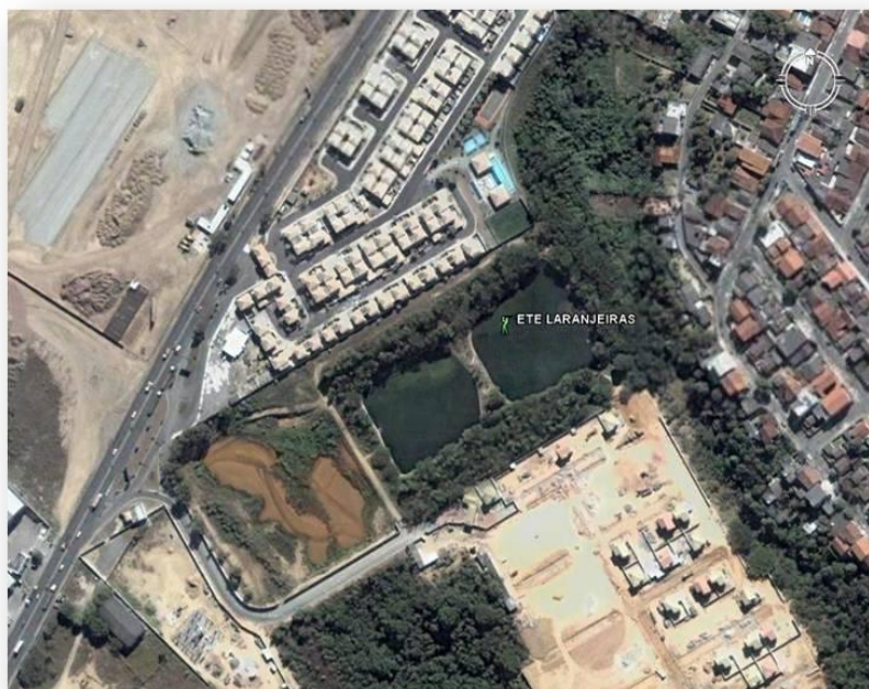
Figura 27 - Visão geral do ETE Laranjeiras
