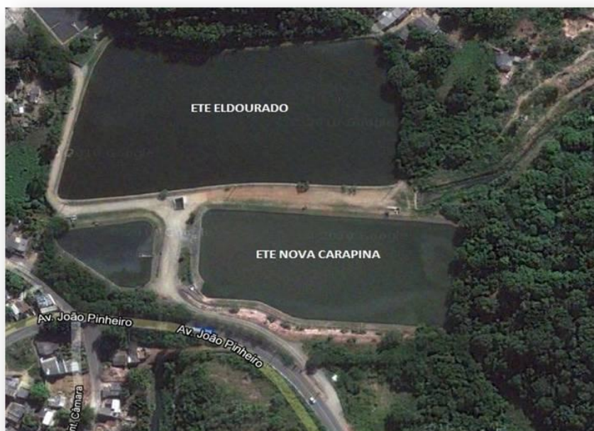
Figura 32 - Visão geral do ETE Nova Carapina
