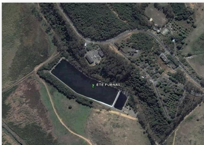
Figura 23 - Visão geral do ETE Furnas
