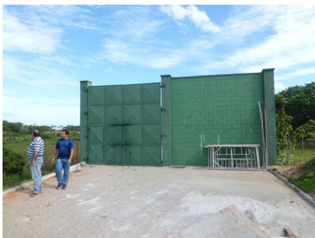
Figura 24: Estação elevatória Riviera Park 3
