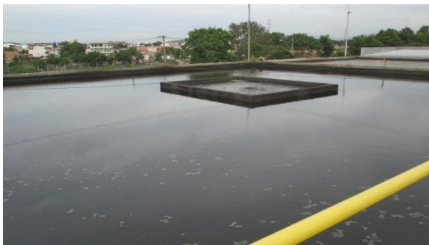
Figura 31: Processo biológico - digestor aeróbio
