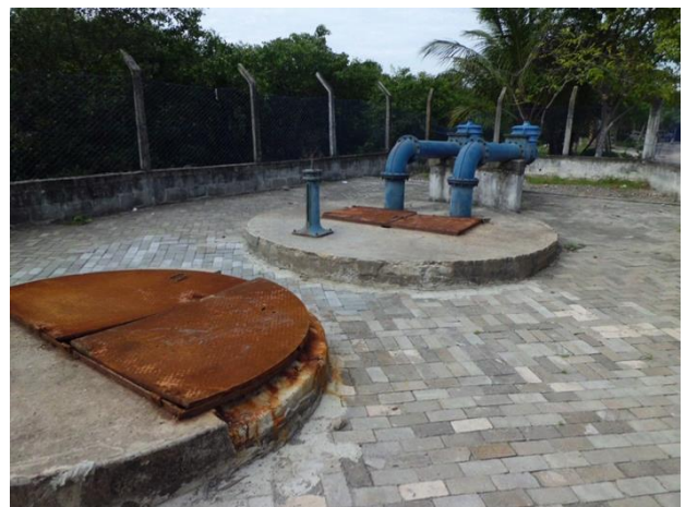
Figura 7: Estação elevatória D. J. Batista
