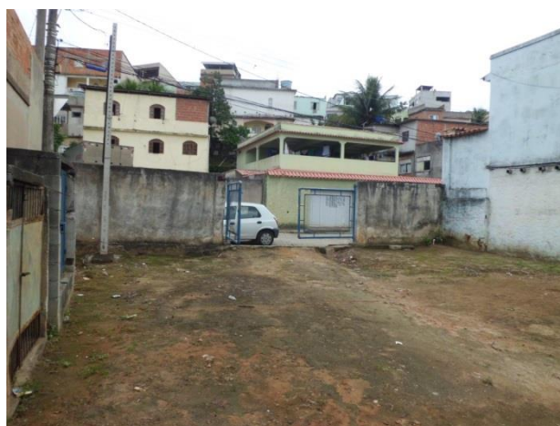
Figura 21: Estação elevatória Rio Marinho
