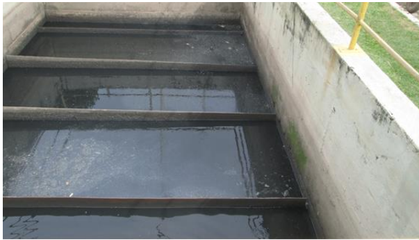
Figura 40: Tratamento preliminar - caixa de gordura
