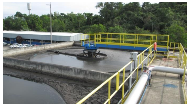
Figura 32: Processo biológico - adensadores 1 e 2
