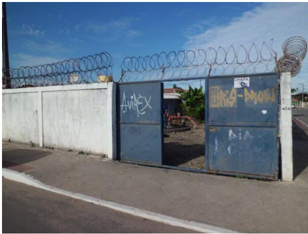
Figura 10: Estação elevatória Jabaeté I
