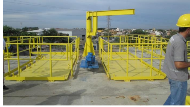
Figura 28: Tratamento preliminar - desarenadores
