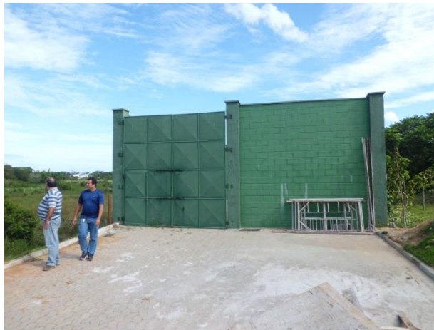
Figura 23: Estação elevatória Riviera Park 2
