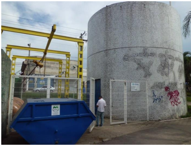
Figura 2: Estação elevatória VVP
