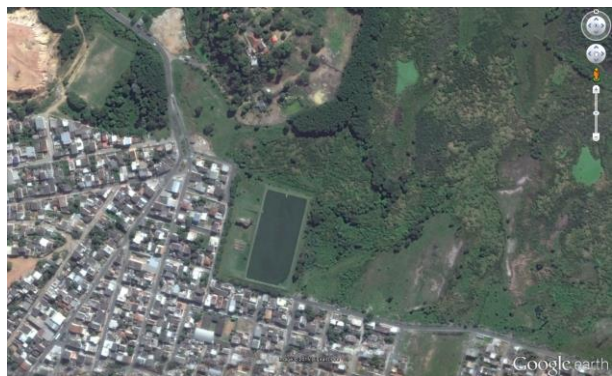
Figura 44: Localização da ETE Vale Encantado Fonte: Google Earth
