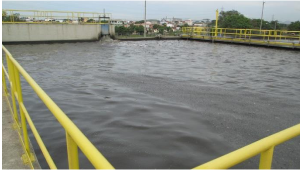
Figura 29: Processo biológico - tanque anóxico
