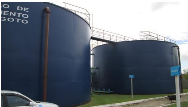
Figura 42: Processo Biológico (UASB+BFAS)
