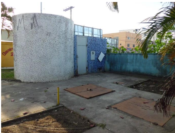
Figura 6: Estação elevatória VVL
