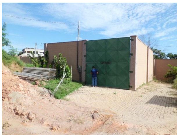
Figura 25: Estação elevatória Riviera Park 4
