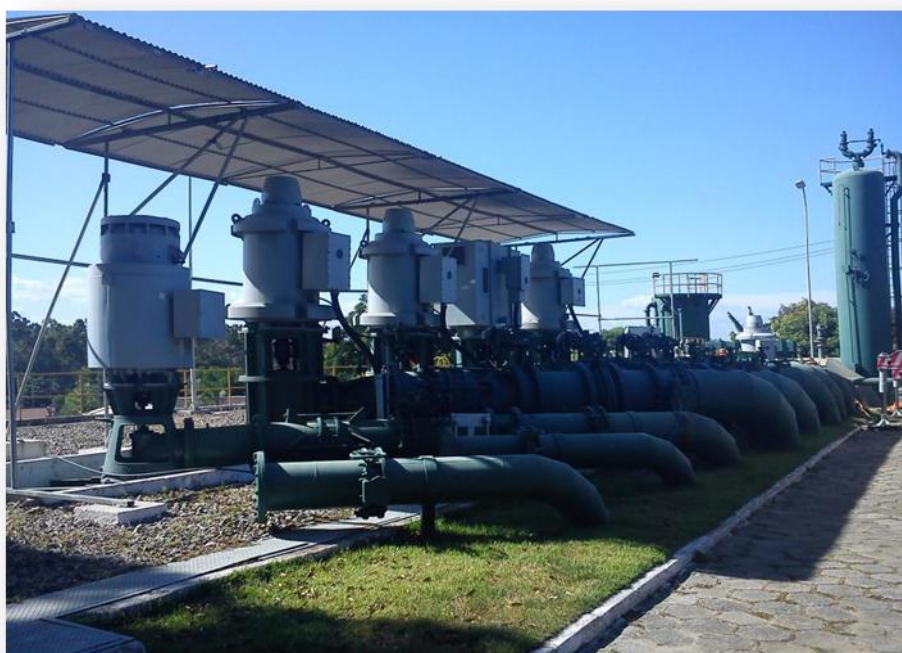
Figura 27 - Estação Elevatória Alto Recalque – EEAR.
