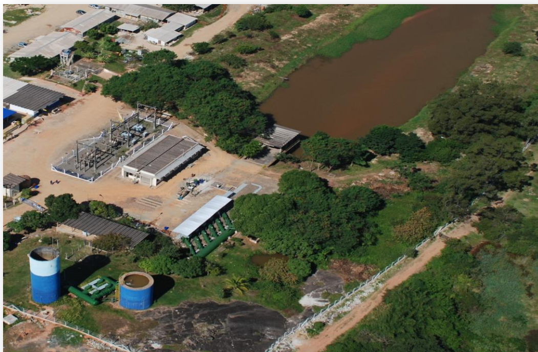
Figura 25 - Captação de água bruta.
