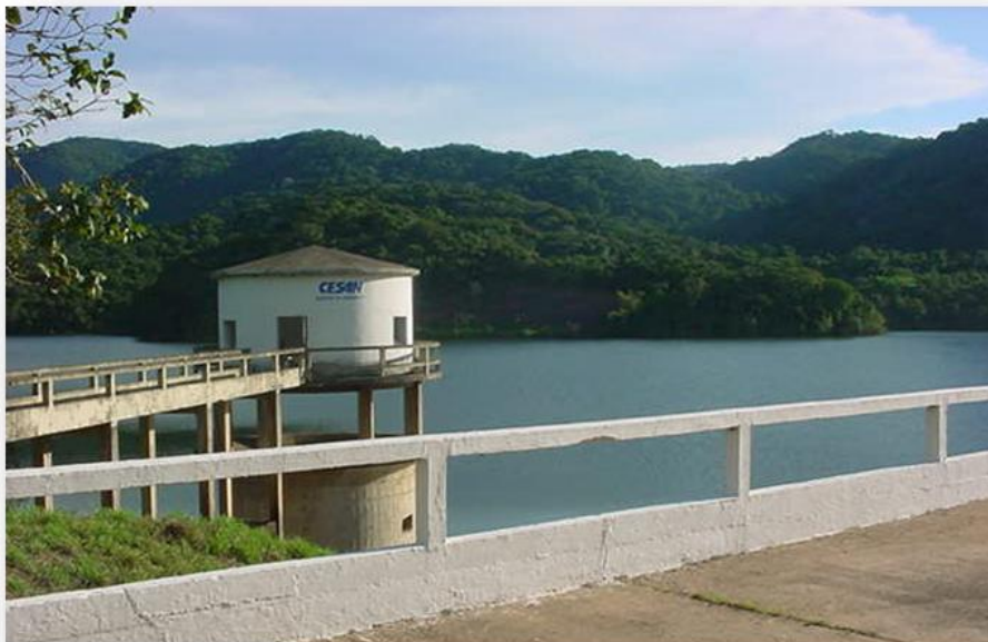
Figura 12: Represa Duas Bocas onde é realizada a captação de água pela CESAN.
