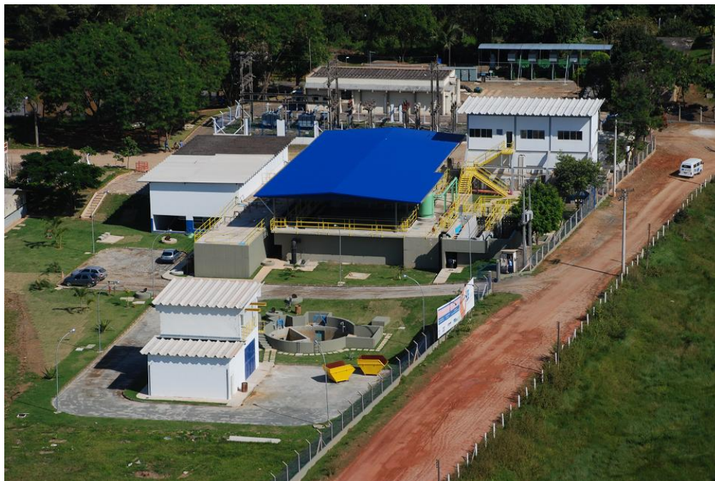
Figura 31 – Estação de Tratamento de Água Caçaroca.
