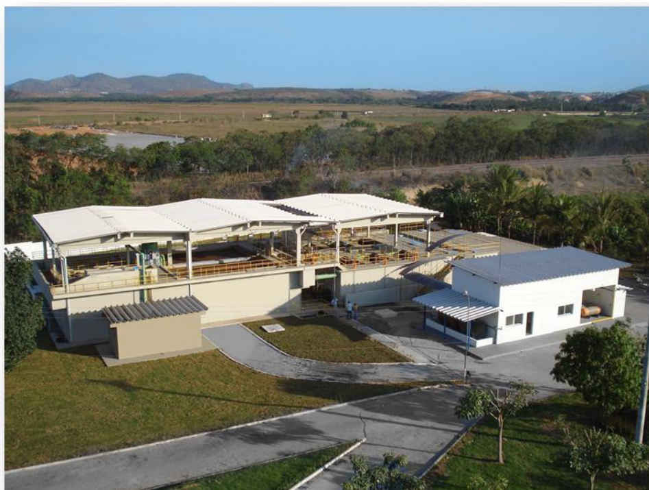
Figura 34 - Estação de Tratamento de Água Santa Maria.
