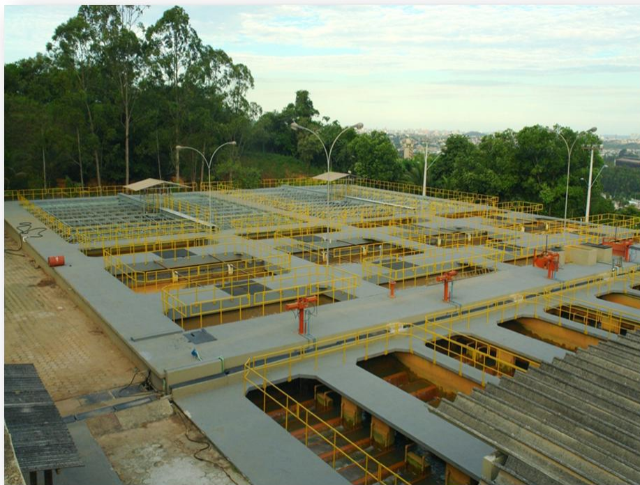
Figura 28 - Estação de Tratamento de Água de Vale Esperança – ETA Nova.
