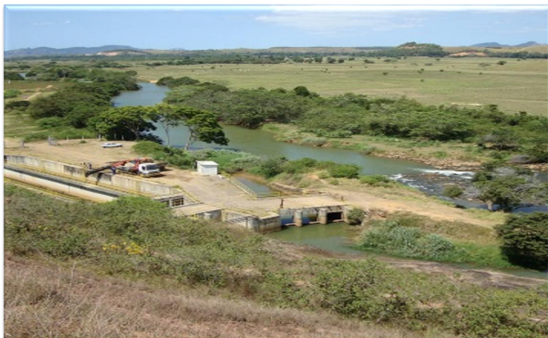
Figura 32 – Captação de água bruta.
