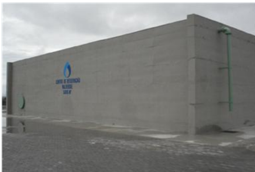
Figura 30 - Reservatório Valverde/Porto de Santana.
