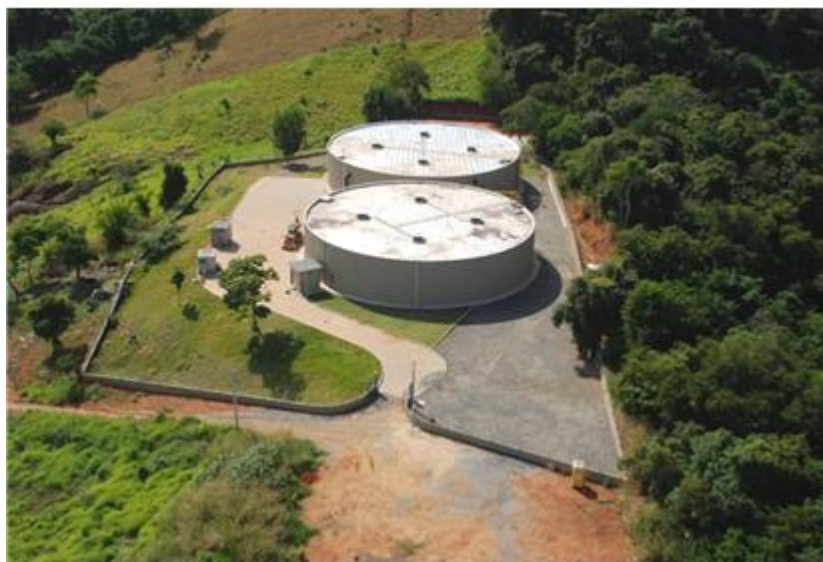
Figura 29 - Reservatório Morro do Pico.
