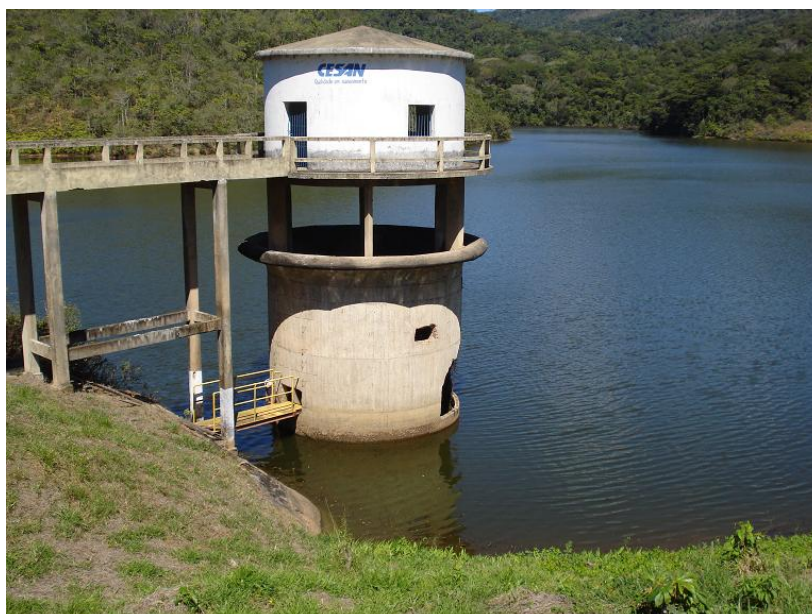
Figura 35 – Captação de água bruta
