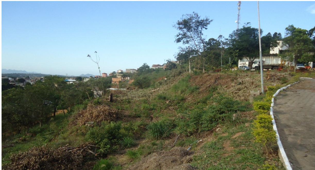
Foto 1: Parte da área destinada ao plantio que foi recentemente atingida por fogo obrigando a Cesan a suprimir árvores nativas e espécies de eucalipto sob risco de queda sobre edificações e/ou funcionários.
