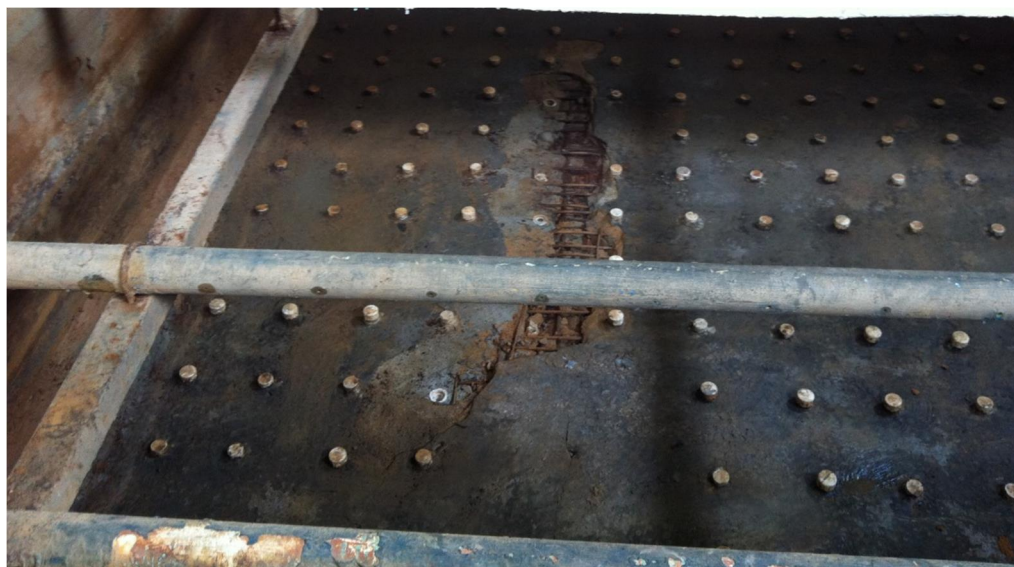
Figura 7 – detalhe da laje da câmara B, filtro 03
