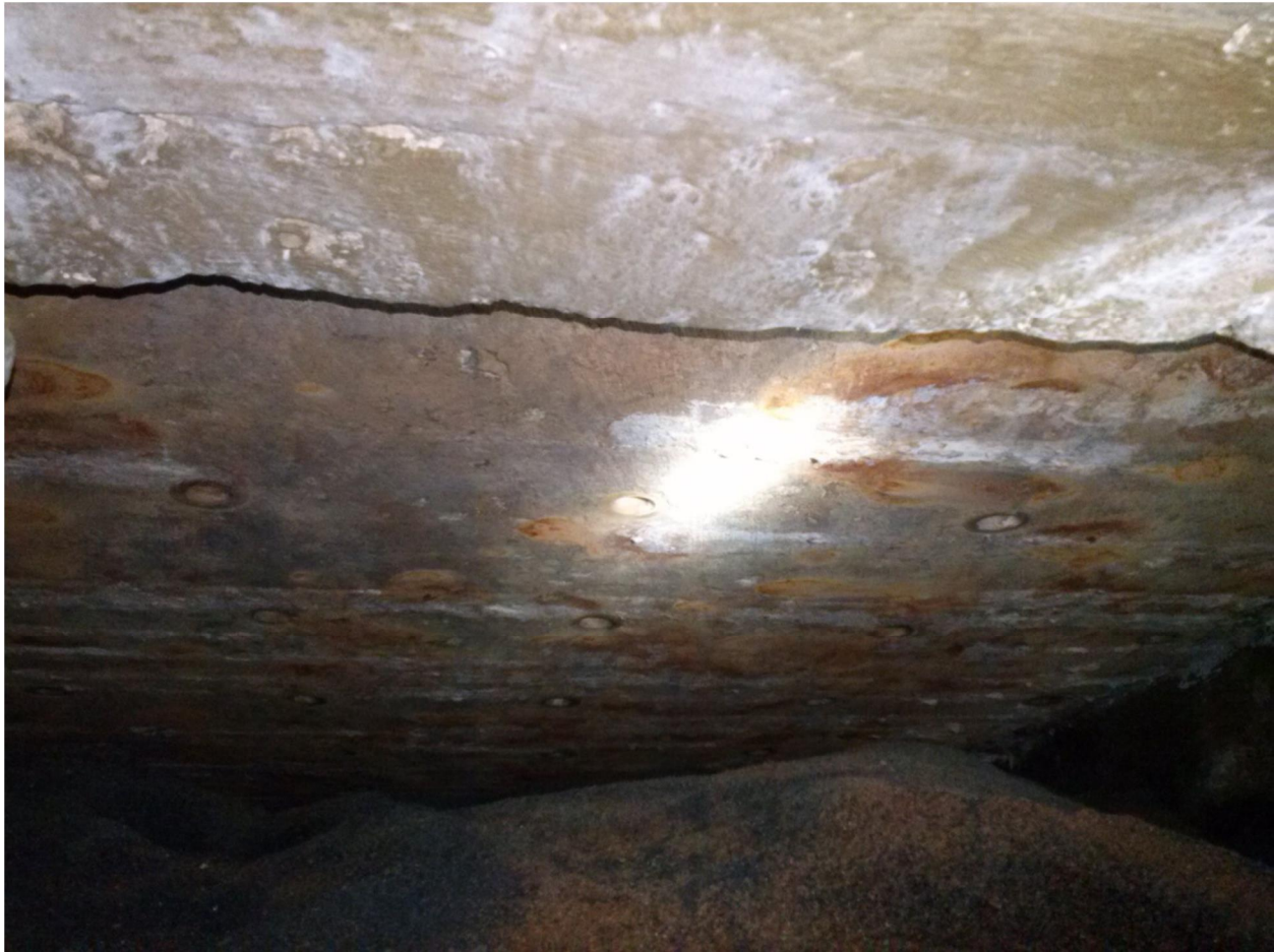
Figura 8 – detalhe da laje da câmara B, filtro 3.
