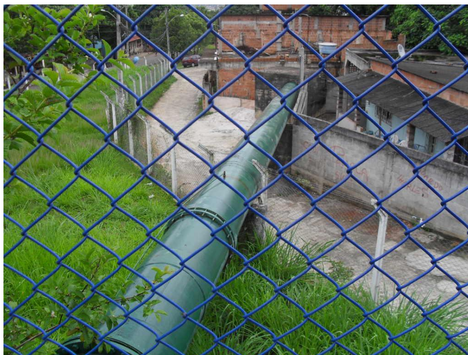
Vista do Trecho Aéreo Oficina
