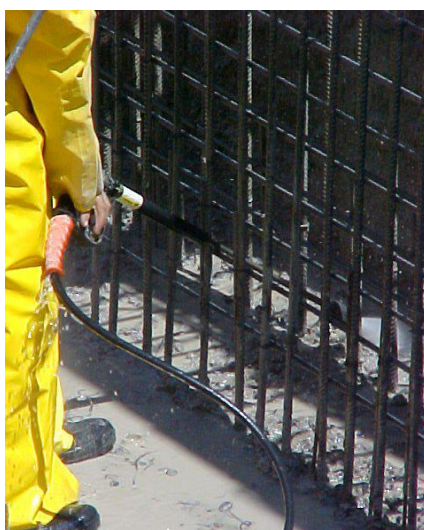
Escarificação e limpeza
