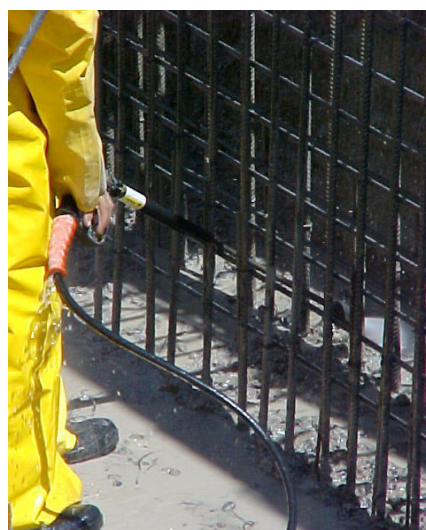
Escarificação e limpeza
