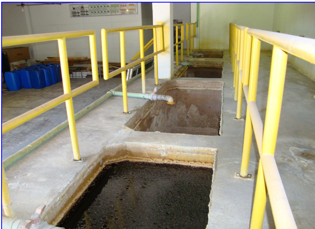
Foto 9 – Manutenção corretiva nos tanques em concreto armado que armazenam sulfato de alumínio (4 unidades), incluindo a aplicação de revestimento em fibra de vidro – Eta V
