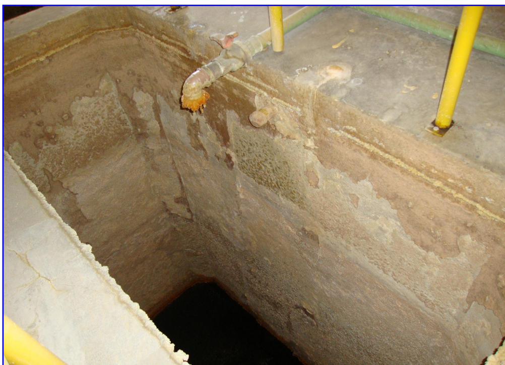
Foto 10 – Condição atual das paredes dos tanques em concreto armado que armazenam sulfato de alumínio – Eta V
