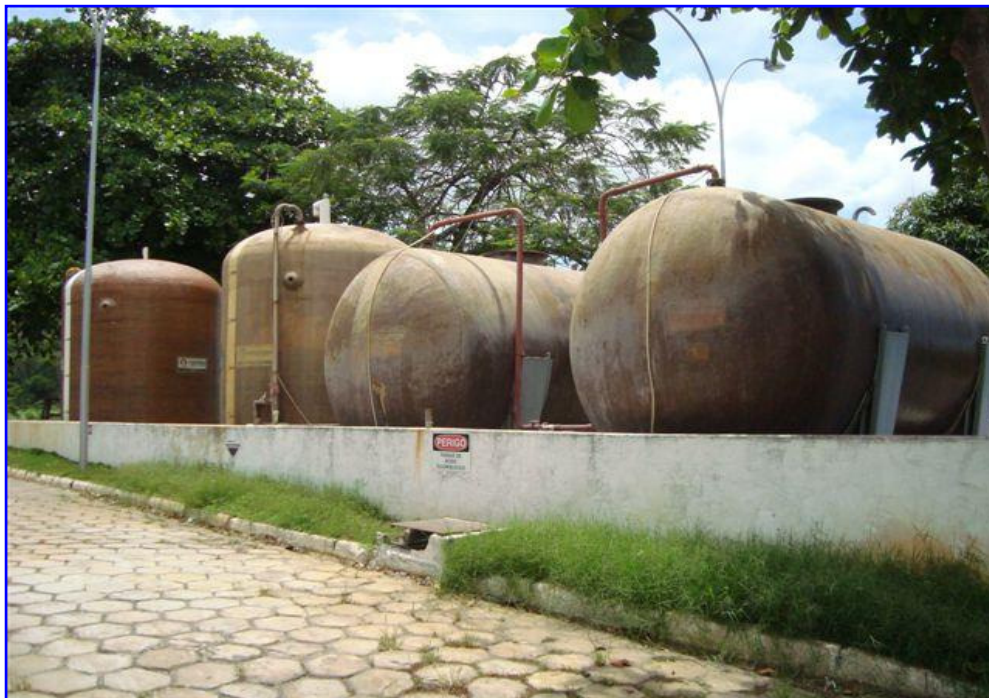
Foto 1 – Manutenção preventiva nos tanques em fibra de vidro que armazenam sulfato de alumínio (2 unidades) e ácido fluorsilícico (2 unidades) – Eta Cobi
