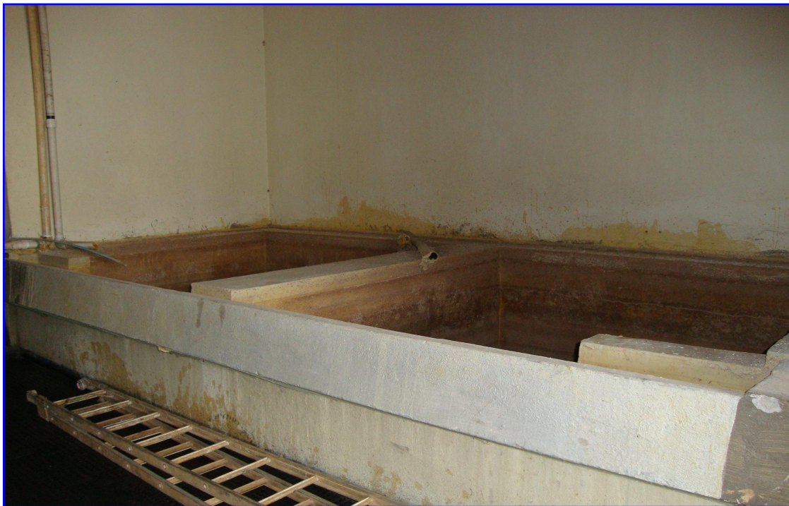
Foto 3 – Manutenção corretiva nos tanques em concreto armado que armazenam sulfato de alumínio (5 unidades), incluindo a aplicação de revestimento em fibra de vidro – Eta Vale Esperança
