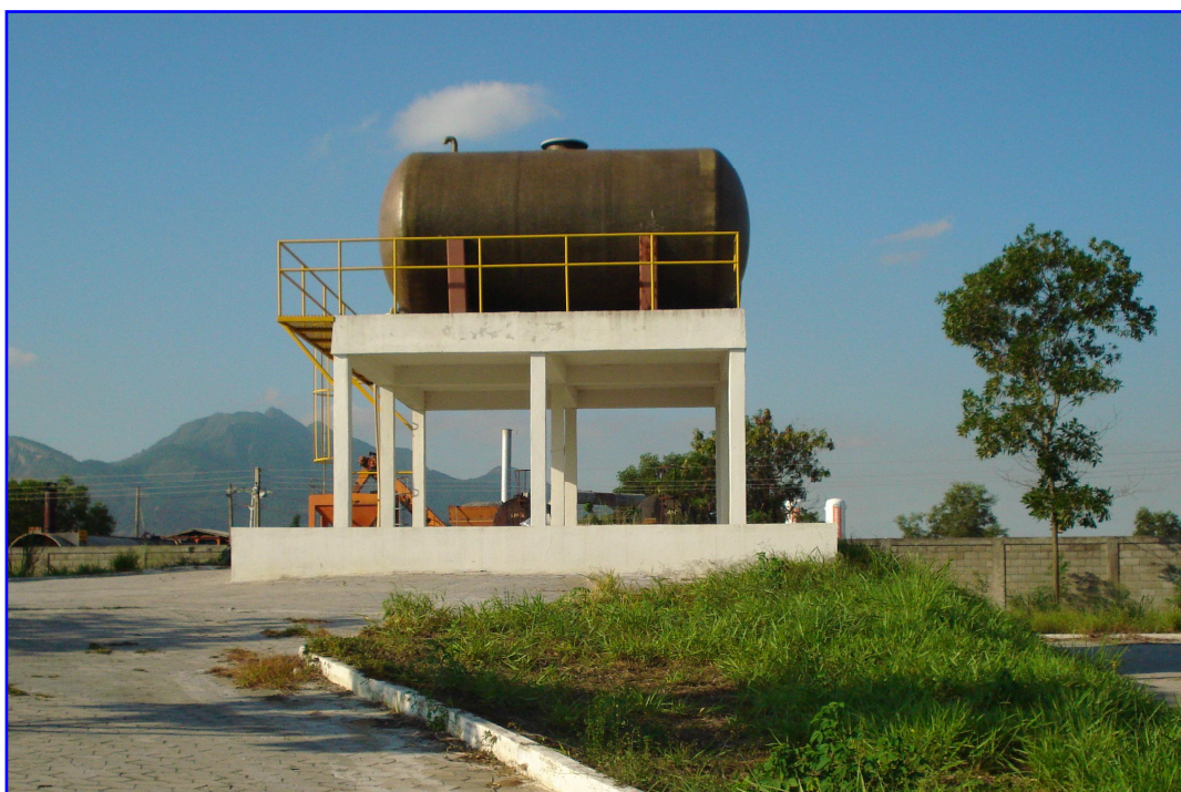
Foto 6 – Manutenção corretiva e preventiva nos tanques em fibra de vidro que armazenam sulfato de alumínio (2 unidades) – Eta Santa Maria
