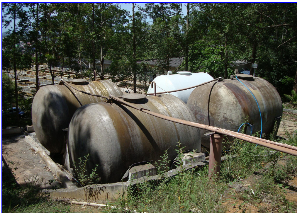
Foto 2 – Manutenção preventiva nos tanques em fibra de vidro que armazenam ácido fluorsilísico (3 unidades) – Eta Vale Esperança
