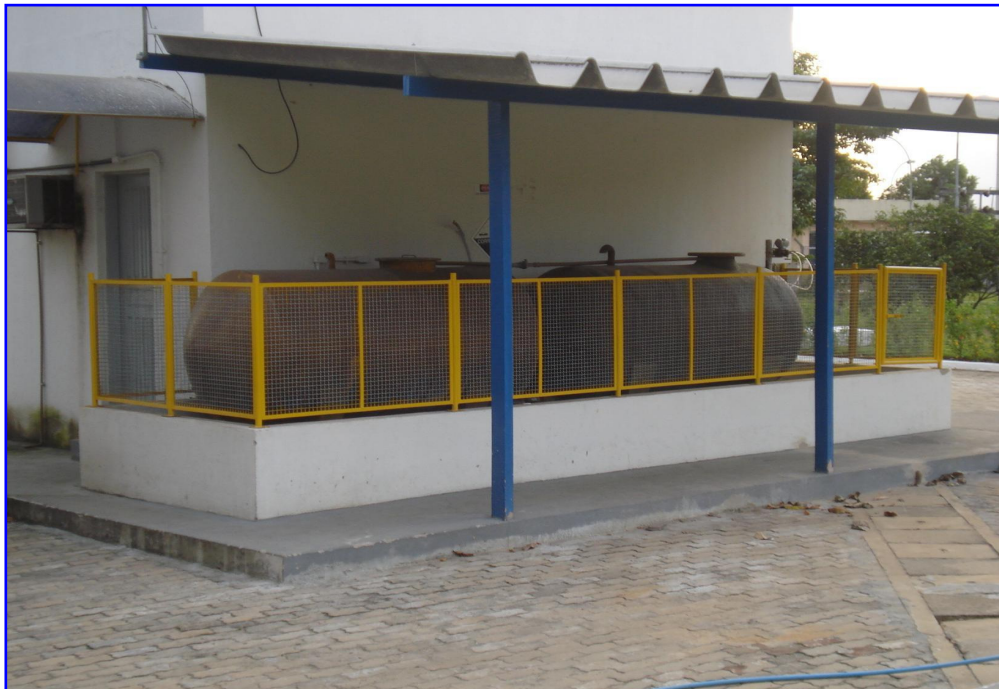
Foto 7 – Manutenção corretiva e preventiva nos tanques em fibra de vidro que armazenam ácido fluorsilícico (2 unidades) – Eta Santa Maria
