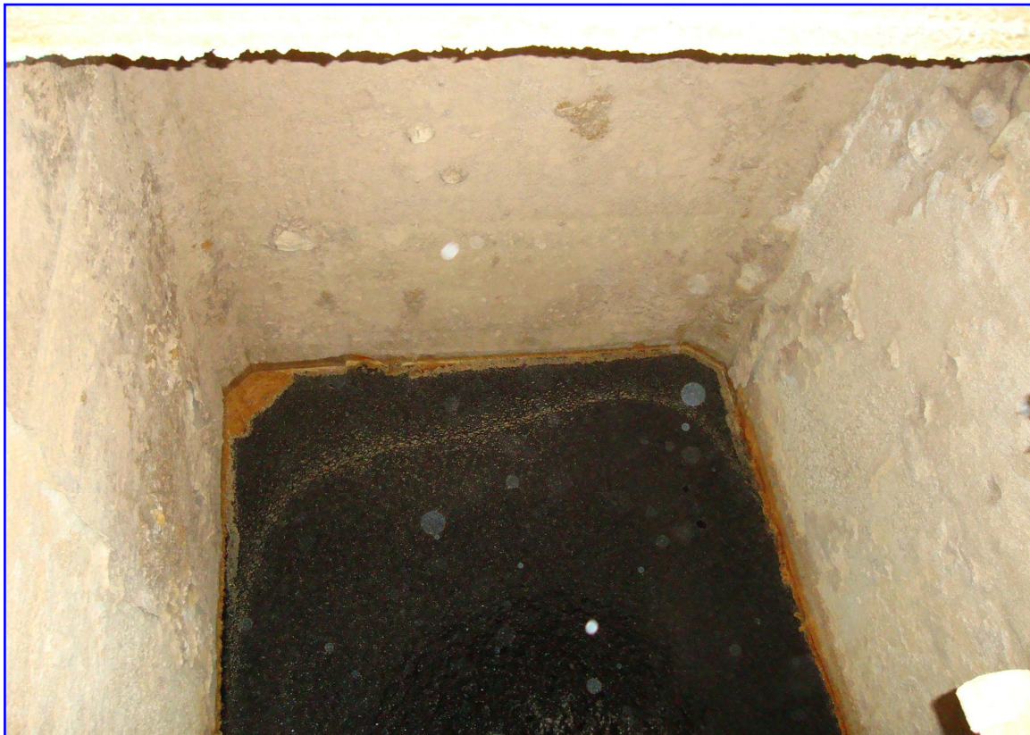
Foto 11 – Condição atual das paredes dos tanques em concreto armado que armazenam sulfato de alumínio – Eta V
