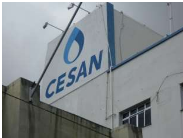
Figura 0.3 - Trajeto inadequado do Subsistema do SPDA
