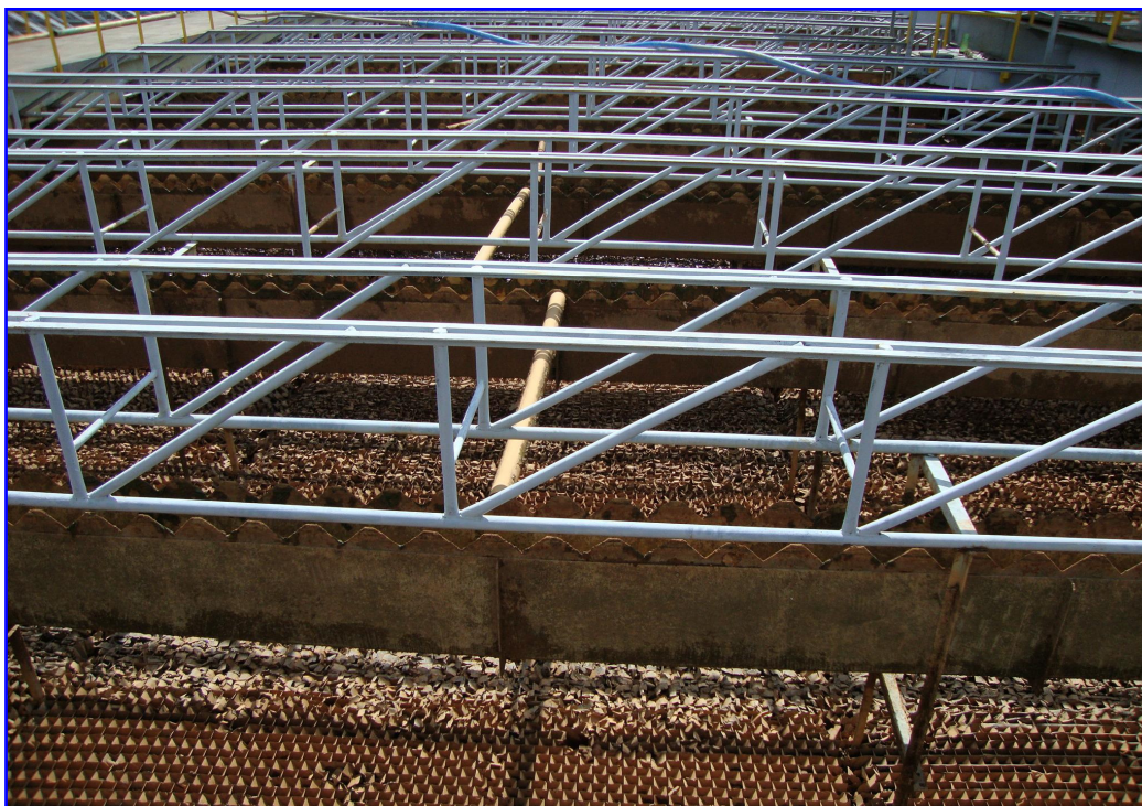
Fotos 1 e 2 – Vista Geral Superior das colméias dos Decantadores
