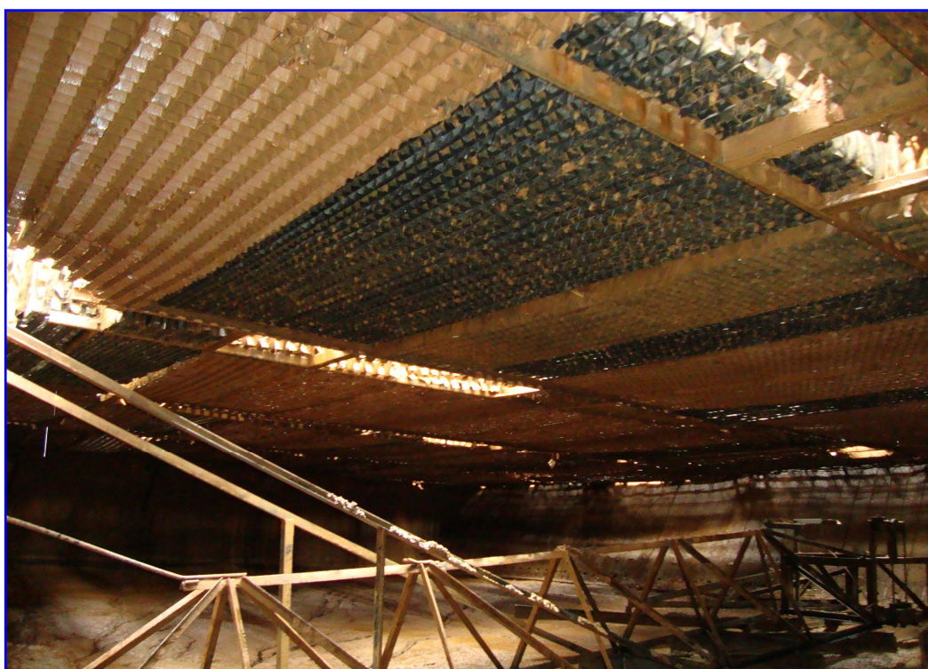
Fotos 3 e 4 – Condições Internas das câmaras dos Decantadores
