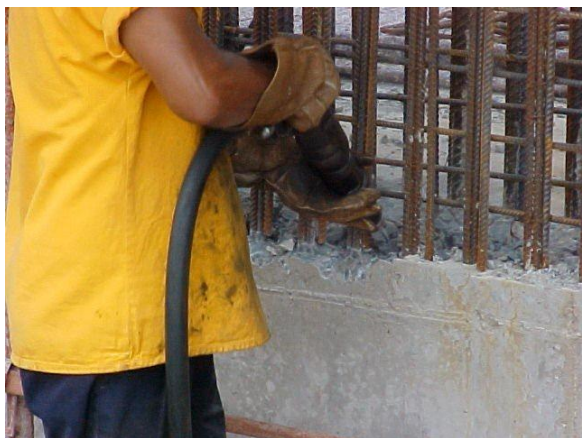
Escarificação, limpeza, colocação do
