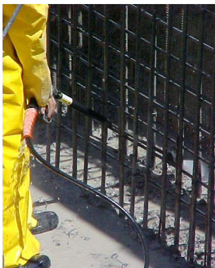
Escarificação e limpeza
