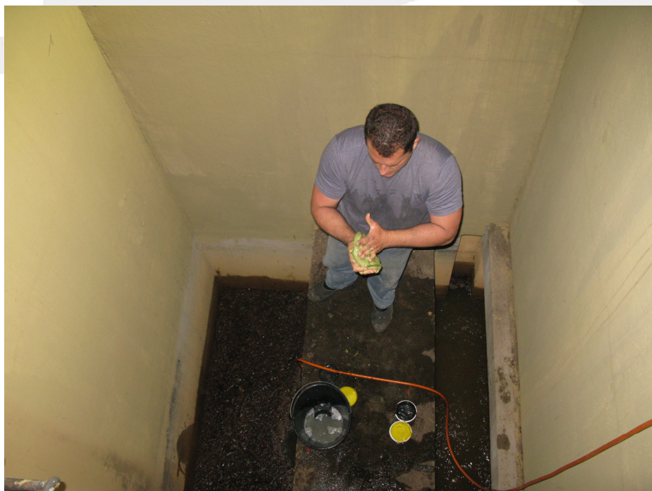
Fig. 17- PREPARAÇÃO DE MASSA EPOXI PARA APLICAÇÃO NO TUBULÃO DA GALERIA.
