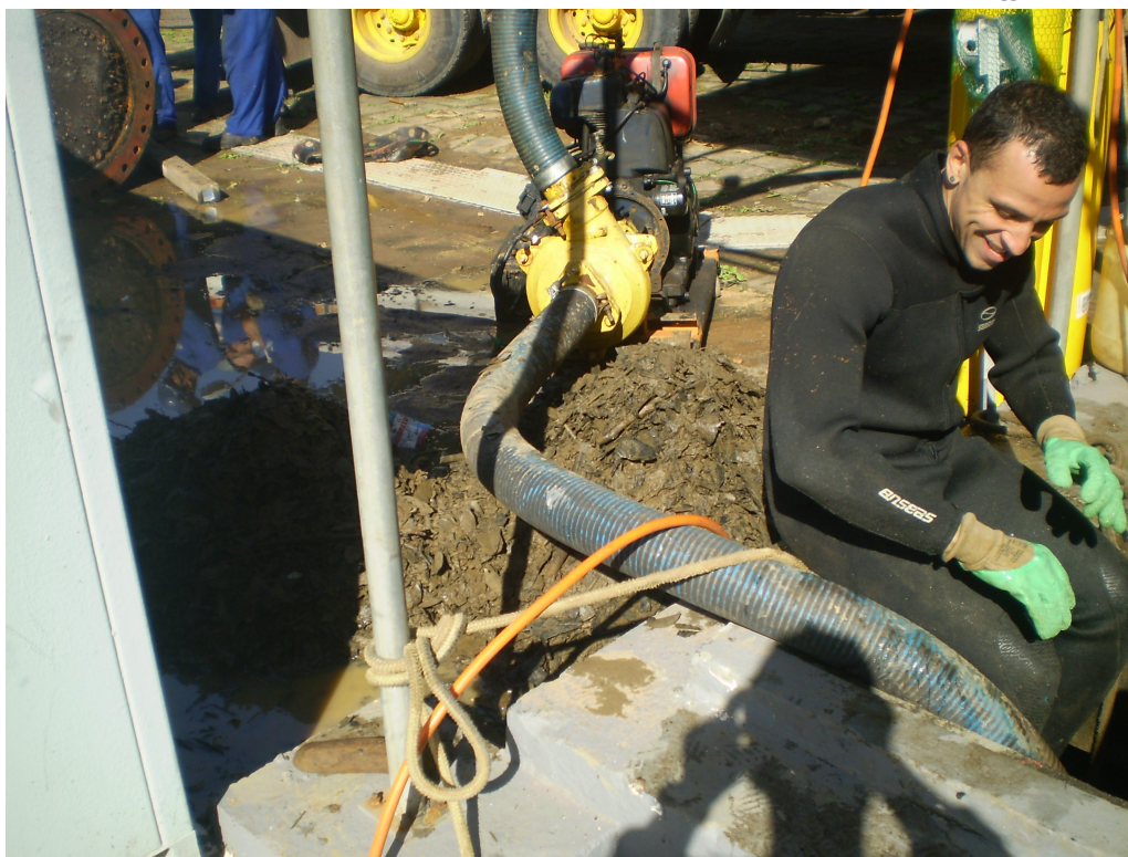
Fig. 8 DRAGAGEM NUM DOS POÇOS DE SUÇÃO .
