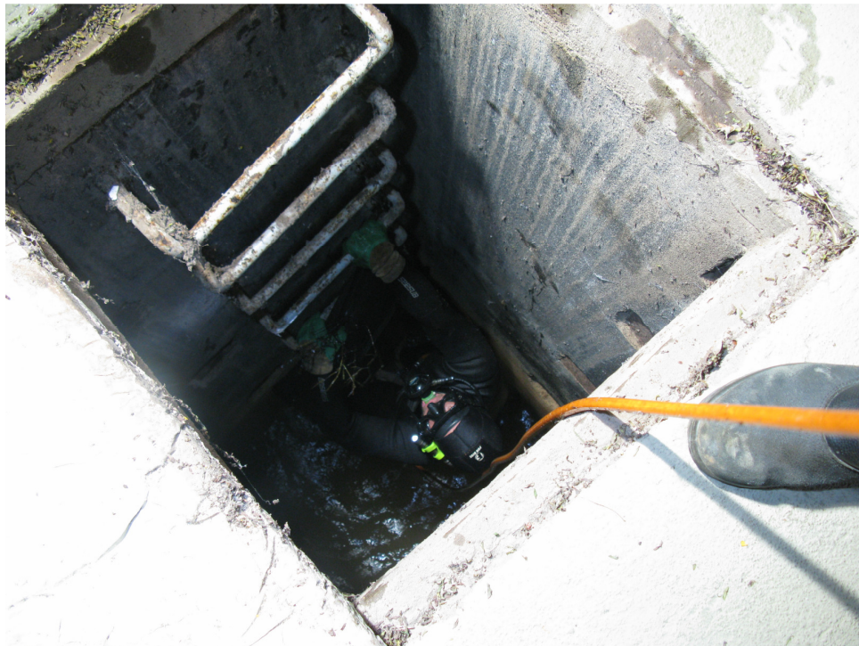
Fig. 16 – AREA DE ACESSO PARA AS GALERIAS.
