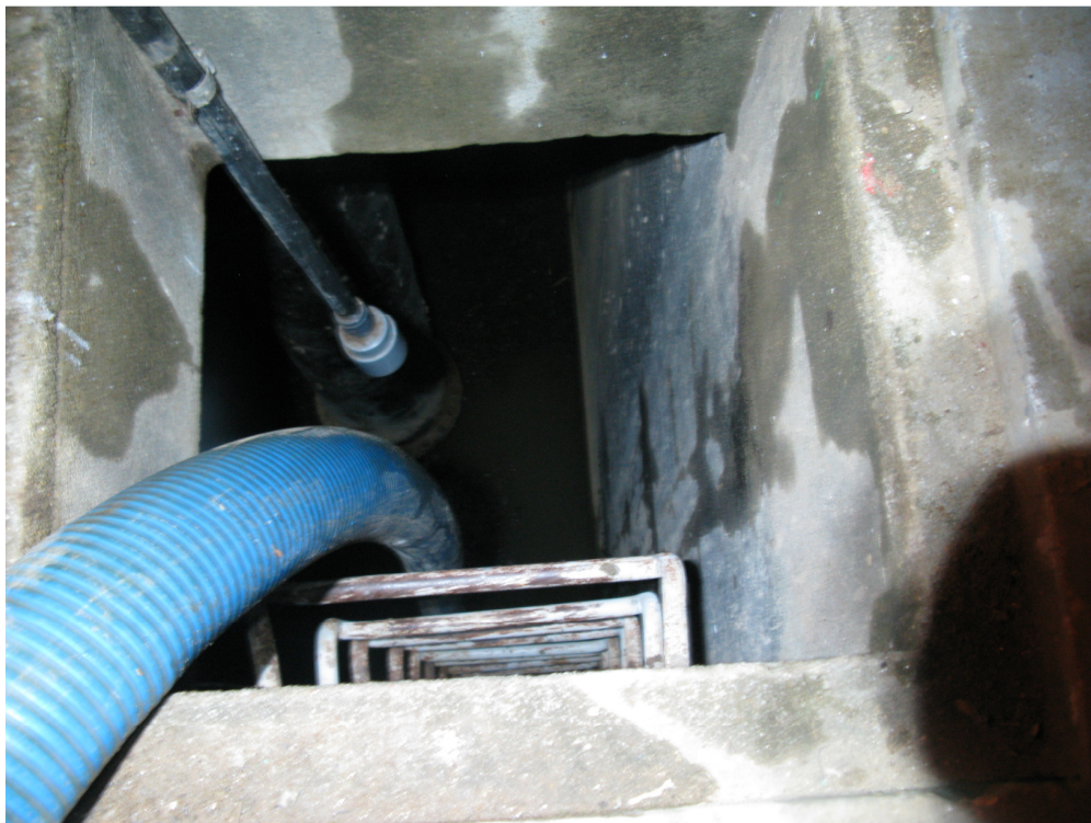
Fig.12 DRAGAGEM SENDO EFETUADA DURANTE A PARALIZAÇÃO DO RESTANTE DO SEDIMENTO ENCONTRADO.
