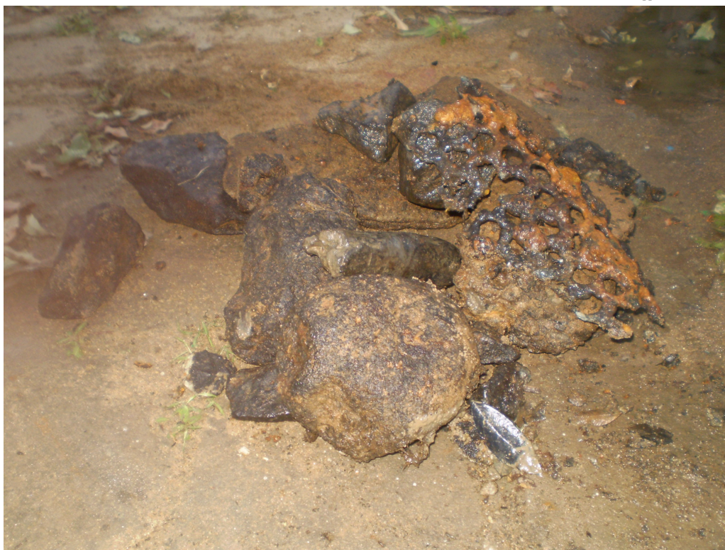
Fig. 2 Retirada de detritos da área das bombas de sucção da elevatória.
