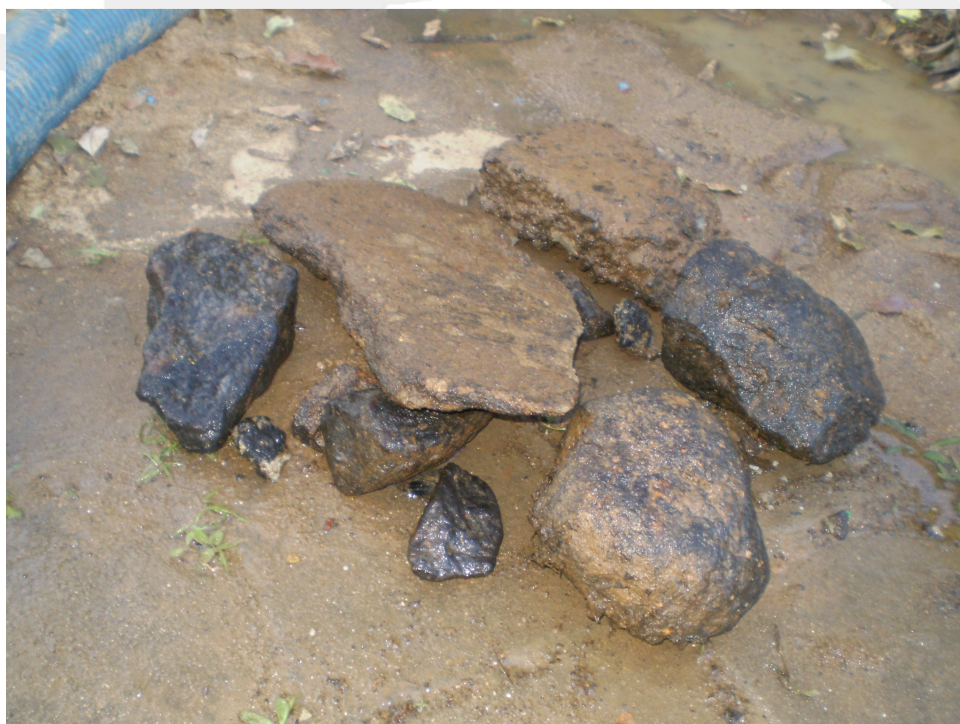
Fig. 3 Retirada de rochas da área das bombas de sucção da elevatória.
