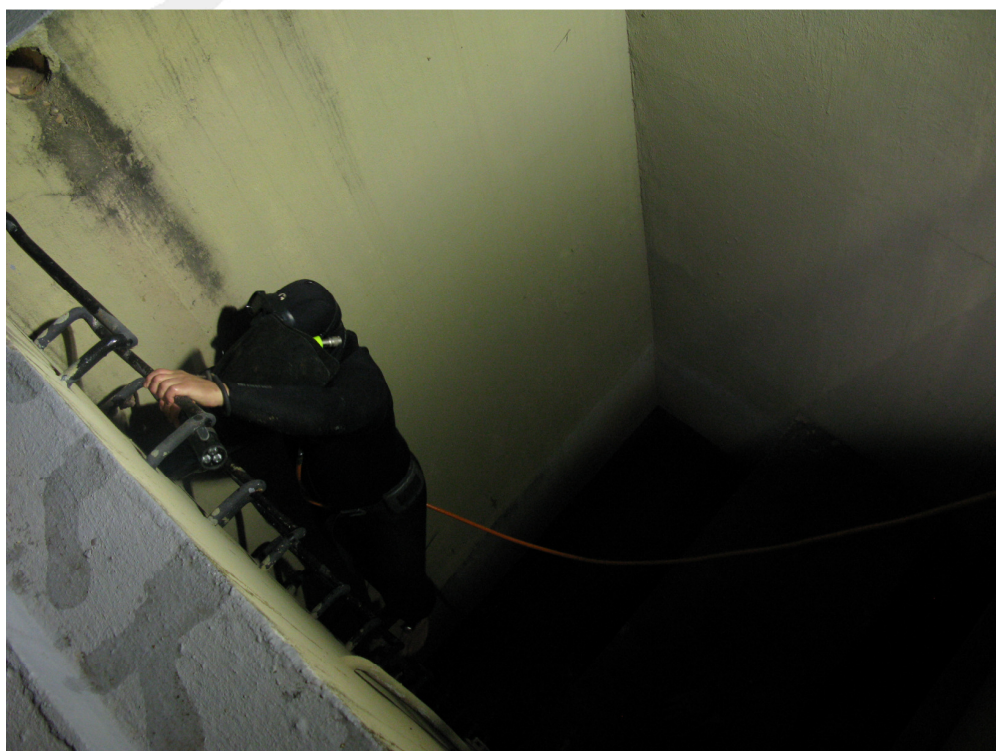
Fig.13 inspeção na galeria.
