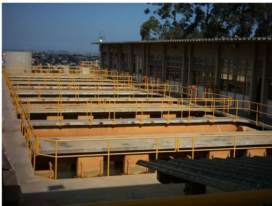
FIGURA 15: VISTA GERAL – ETA ENG o HELDER FARIA VAREJÃO – ETA VALE ESPERANÇA
