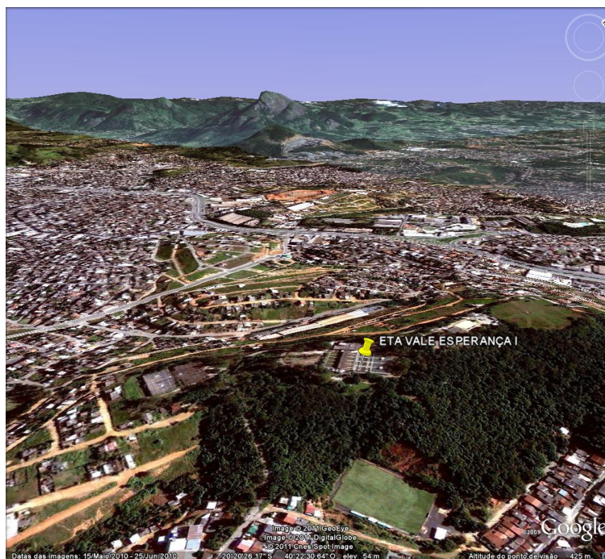
FIGURA 11: VISTA EM RELEVO DA ETA ENGº HELDER FARIA VAREJÃO – ETA VALE ESPERANÇA
