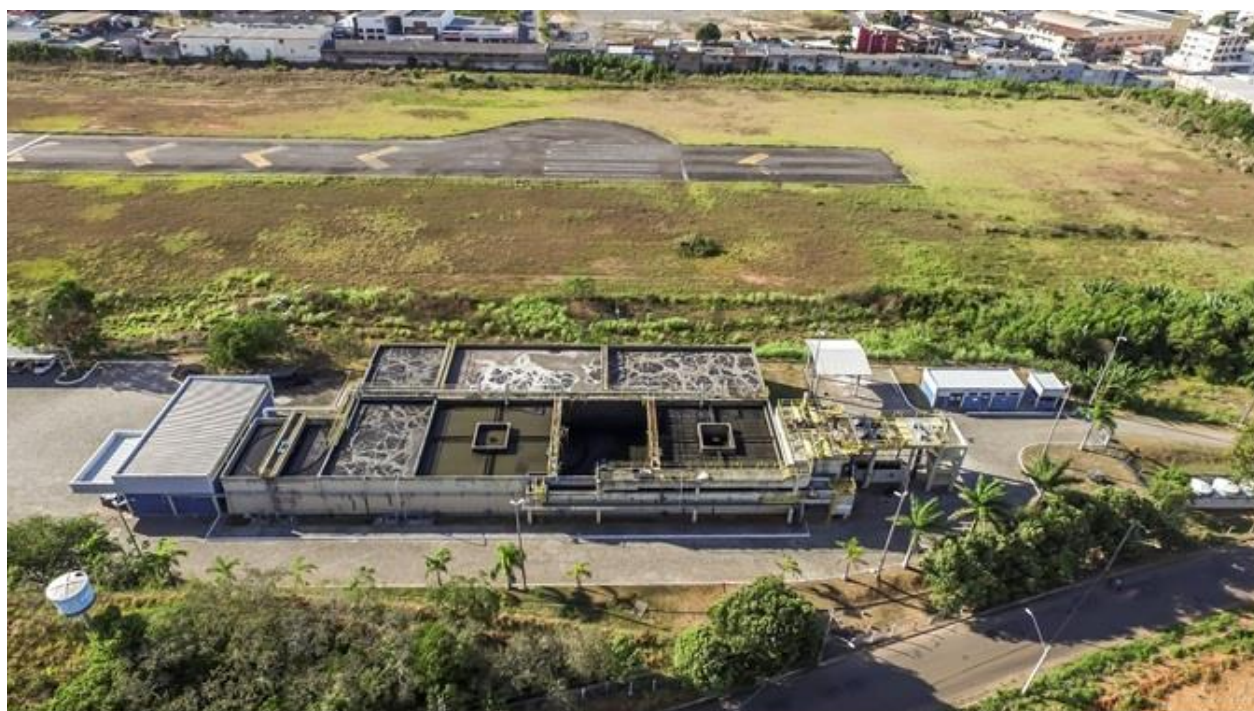
Vista aérea da ETE Aeroporto
