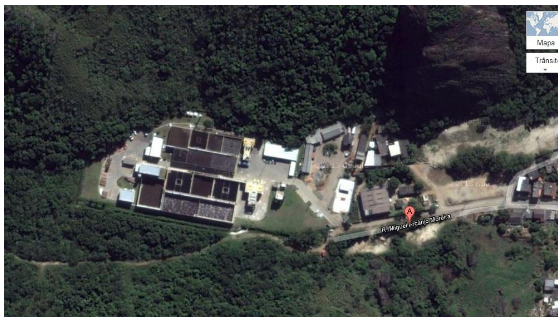
Foto da ETE Mulembá I e II (Google Earth)
