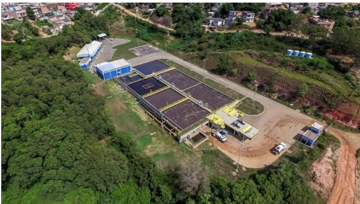
Vista aérea da ETE Bandeirantes
