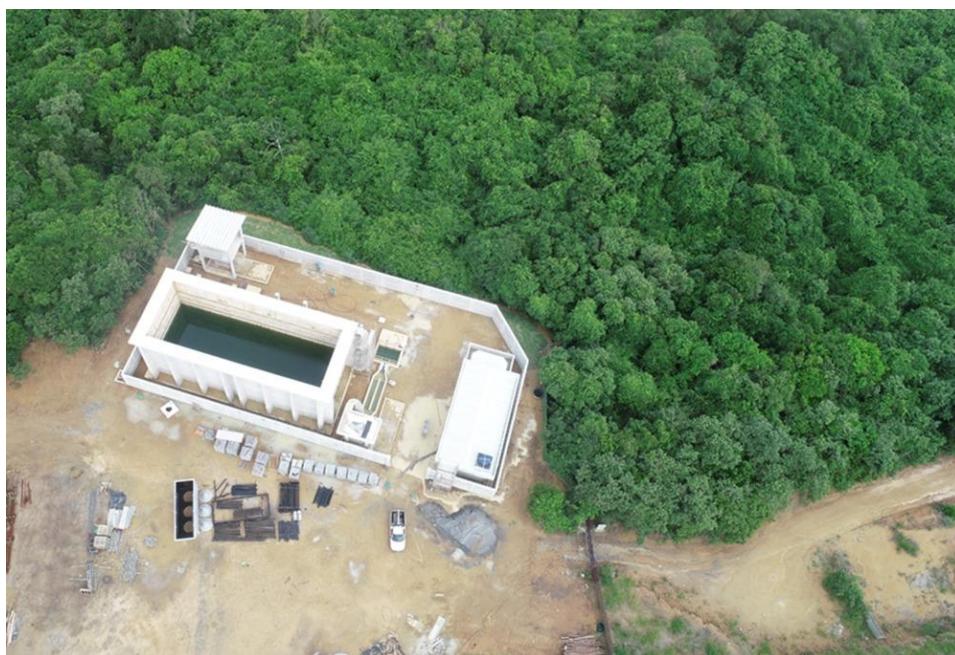
Foto aérea da ETE Barra do Sahy (fase de obras).
