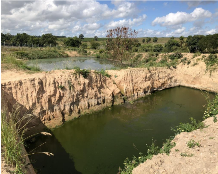
Figura 6 – Vista da lagoa em operação.
