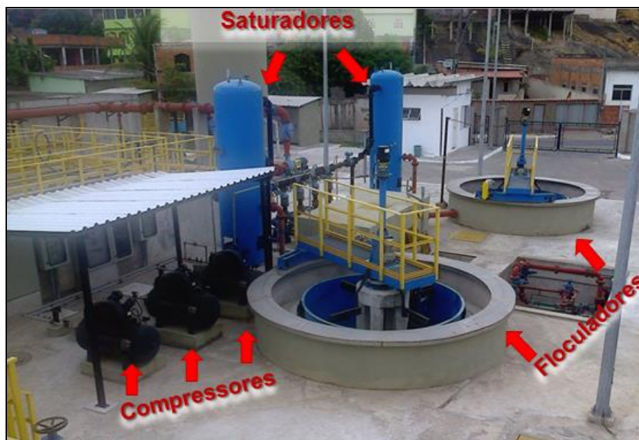
Figura 11: Sistema de flotação.
