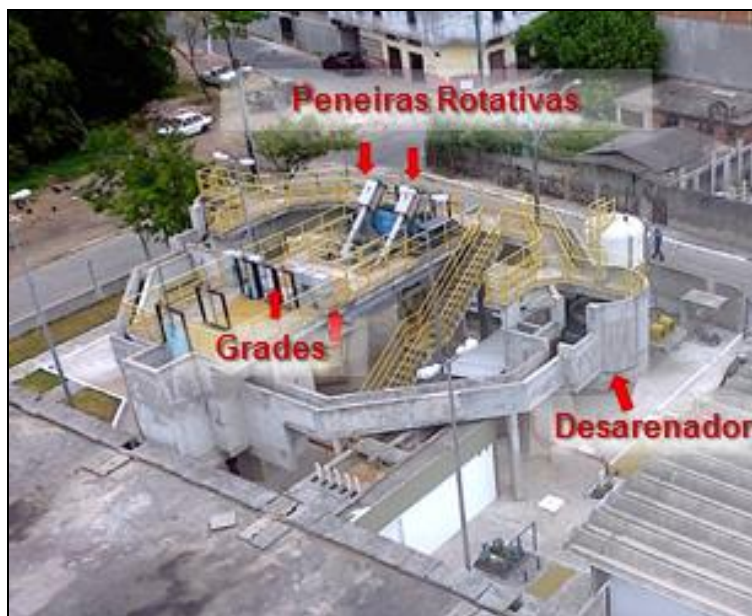
Figura 9: Visão geral da etapa do tratamento preliminar
