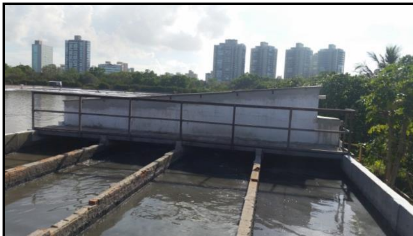
Figura 4: Visão geral da etapa do tratamento preliminar
